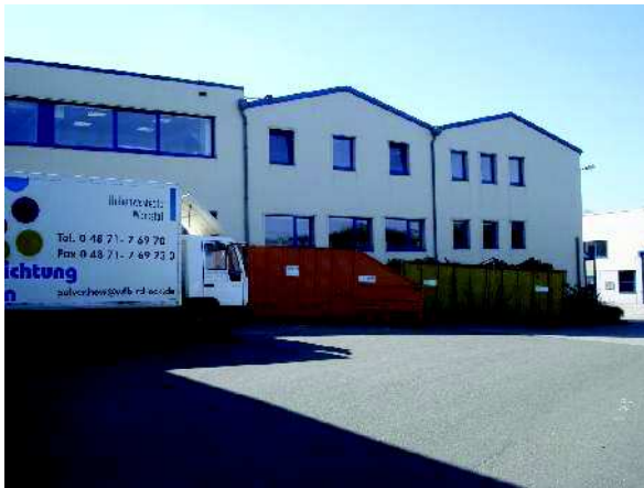
Abb. 26 Blick von den Betriebsflächen nahe der Itzehoer Straße auf die Betriebsgebäude der ersten Entwicklungsphase (P. Scharlibbe 14.04.2011)
