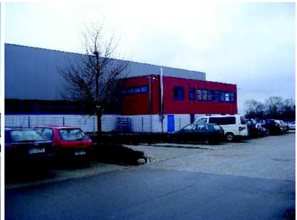
Abb. 27 Blick von der Stellplatzanlage auf den letzten Bauabschnitt am Ende des Betriebs- und Produktionsgebäudes (P. Scharlibbe 16.01.2011)
