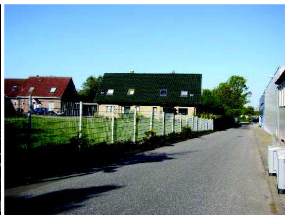
Abb. 12 Blick von Osten entlang der Betriebs- umfahrt auf die vorhandene Bebauung Leserkamp Haus Nr. 9c-d und Nr. 9d-f (R. Pollok 03.05.2011)
