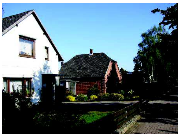
Abb. 11 Blick von Süden auf die vorhandene Bebauung westlich der Itzehoer Straße Haus Nr. 67 und 69 (R. Pollok 03.05.2011)
